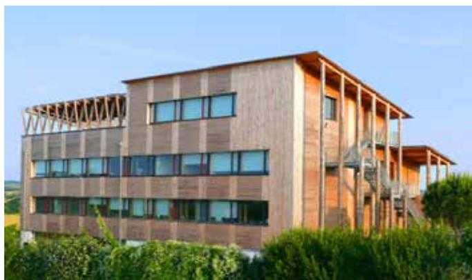
Basé en France, dans le Gers, le siège du Groupe ECOCERT est un bâtiment à énergie positive : ossature bois, isolation en paille, faible consommation d'énergie, panneaux solaires...
